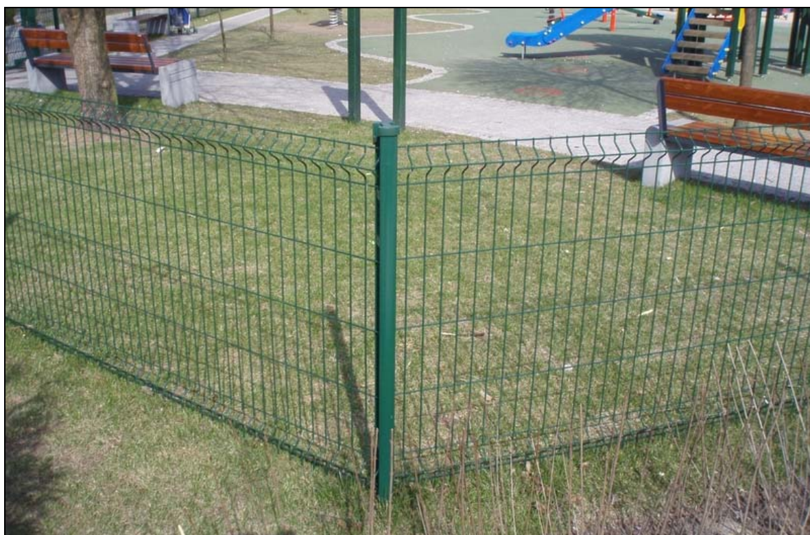
Fot.3 Projektowany typ ogrodzenia panelowego.
